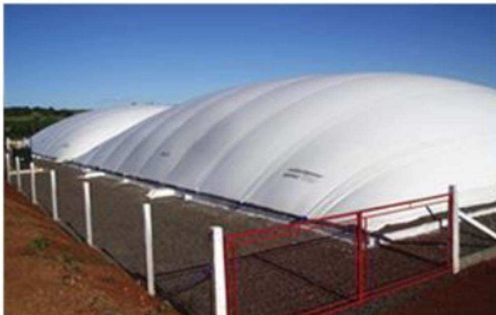
**Figura 2.5:** *Biodigestor modelo lagoa coberta.*
