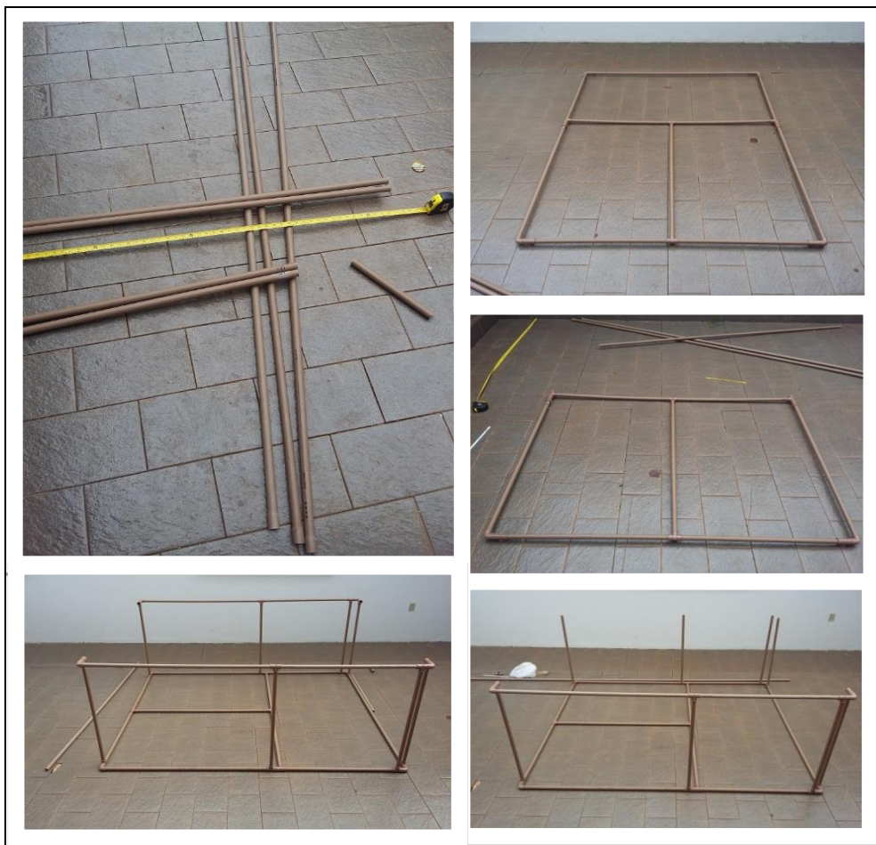
Figura 5: montagem da estrutura do palco do teatro
