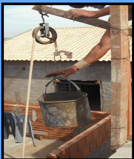
Figura 6 – Uso de roldana na construção
